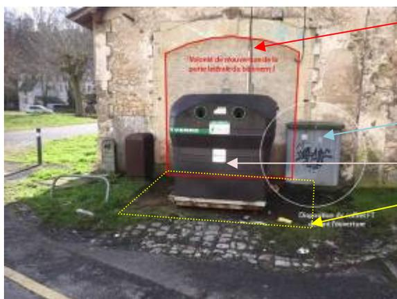
Sur la façade nord du bâtiment, figure un appareillage de pierre d'angle surmonté d'un arc surbaissé, traduisant la présence d'une ancienne ouverture. Dans le cadre du projet, et en fonction du parti-pris choisi, il pourrait être étudié la possibilité de rouvrir ou de mettre en valeur cette ancienne entrée.
