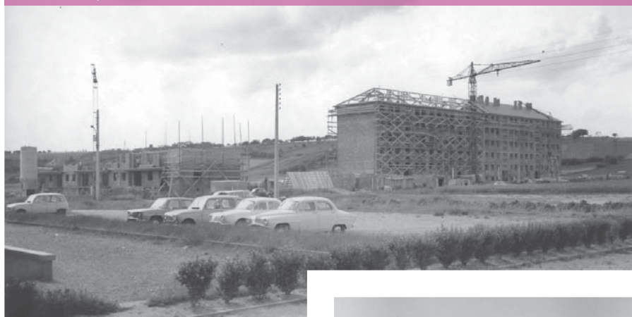
Construction du quartier
