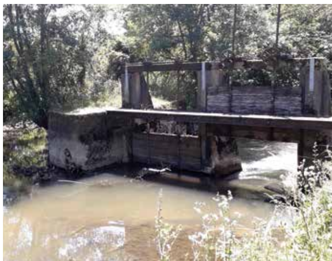
7 L'OUVRAGE AVANT LES TRAVAUX
