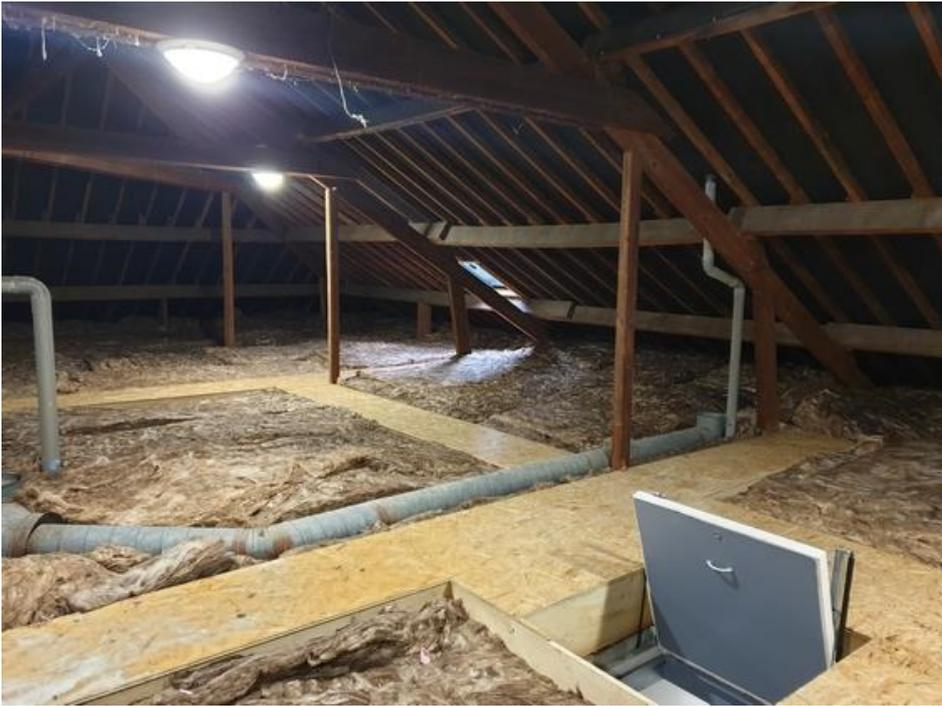
Les câbles chemineront, du coffret de distribution jusqu'aux dispositifs antenne et caméras, dans le grenier le long des pannes de la charpente.
