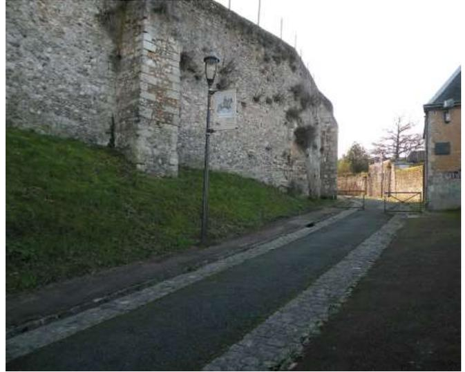
Le front nord est constitué d'un ancien mur de défense entrecoupé par la tour n°3 et n°4. Le mur et les tours présentent des lacunes importantes de pierres, les joints sont à certains endroits lessivés et certaines fissures sont importantes. Des travaux de conservation s'avèrent nécessaires.
